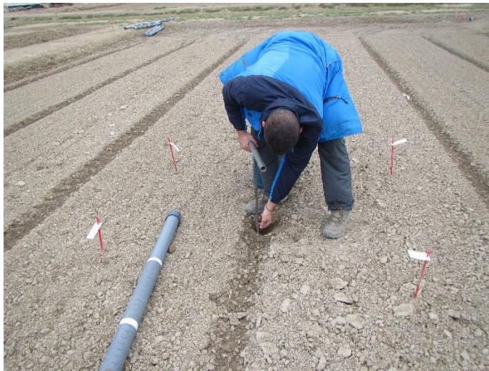
Imatge 30. Instal·lació dels piezòmetres
